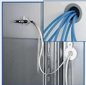
Passage de cuve Ø 15mm pour sonde GTC (Gestion Température Centralisée) PT100 ou numérique, et passage de cuve Ø 30mm pour caractérisation/qualification sur site positionné sur le coté droit à 1/3 du haut.
